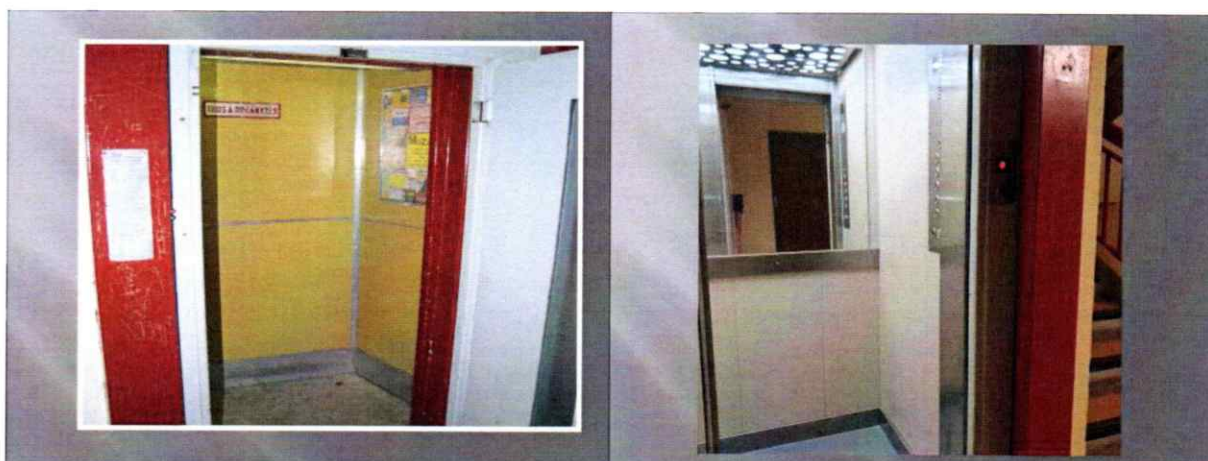
LIFT SZEKRENY FELÚJÍTÁSA
